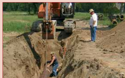
▲ Nach den Abrissarbeiten in den letzten Jahren kündigen die Bagger heute den Neuaufbau an: Die ersten Abwasserleitungen werden verlegt
