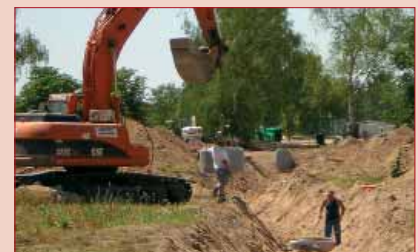
▲ Nach den Abrissarbeiten in den letzten Jahren kündigen die Bagger heute den Neuaufbau an: Die ersten Abwasserleitungen werden verlegt
